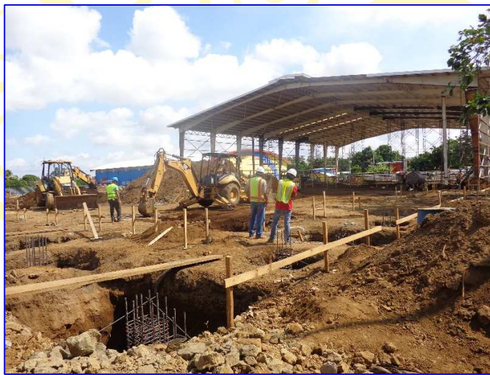
Panorámica costado Oeste del Gimnasio de Baloncesto en el Polideportivo España, donde se aprecia la ejecución de la etapa de fundaciones en la cancha alterna.
